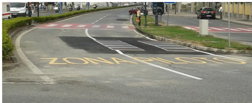
Fig. 4. Instalação piloto do sistema Waynergy Vehicles
