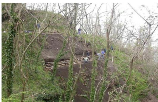
**Fig.3. 1ª Fase: Construção de muro vivo, maio 2004**
