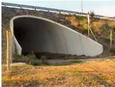
Construção de passagem de fauna de grande porte.
