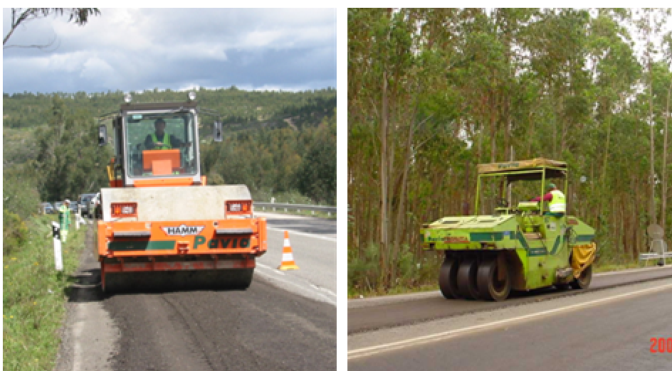
Figura 4 – Compactação da camada reciclada
