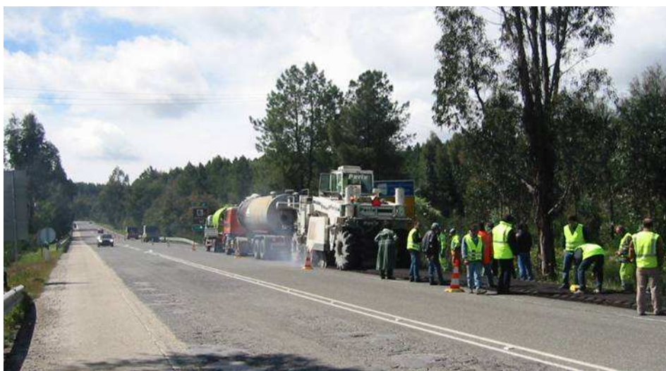
Figura 3 – Trabalhos de reciclagem do pavimento
