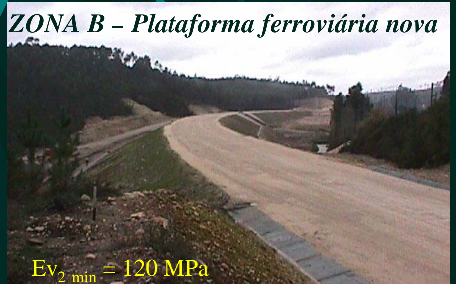
Camada de 30 a 45 cm de enrocamento calcário
