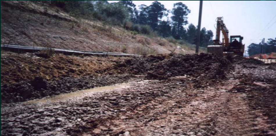
Plataforma das terraplenagens em más condições
