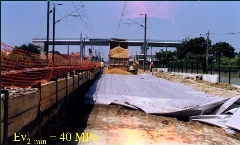
Plataforma das terraplenagens em más condições
