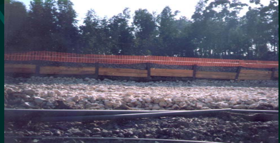
Camada de 30 a 45 cm de enrocamento calcário
