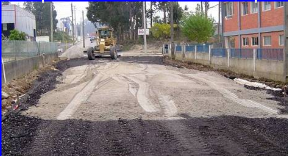
Espalhamento fresado e pó
