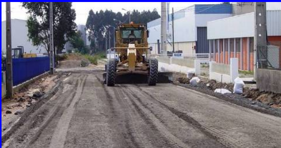
Nivelamento da Mistura
